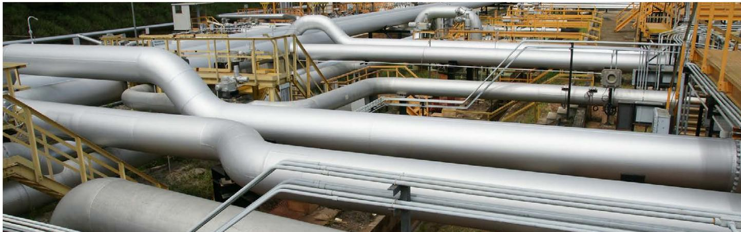
La proyección de alambre por combustión se emplea en la industria petrolera y del gas para la protección anticorrosión, inclusive para prevenir de forma duradera la corrosión bajo aislamiento (en inglés, CUI).
